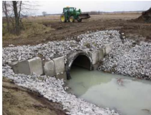
Exemples de travaux effectués : Stabilisation des berges (gauche) et stabilisation de ponceau (droite) Source : [www.cobamil.ca](http://www.cobamil.ca)
